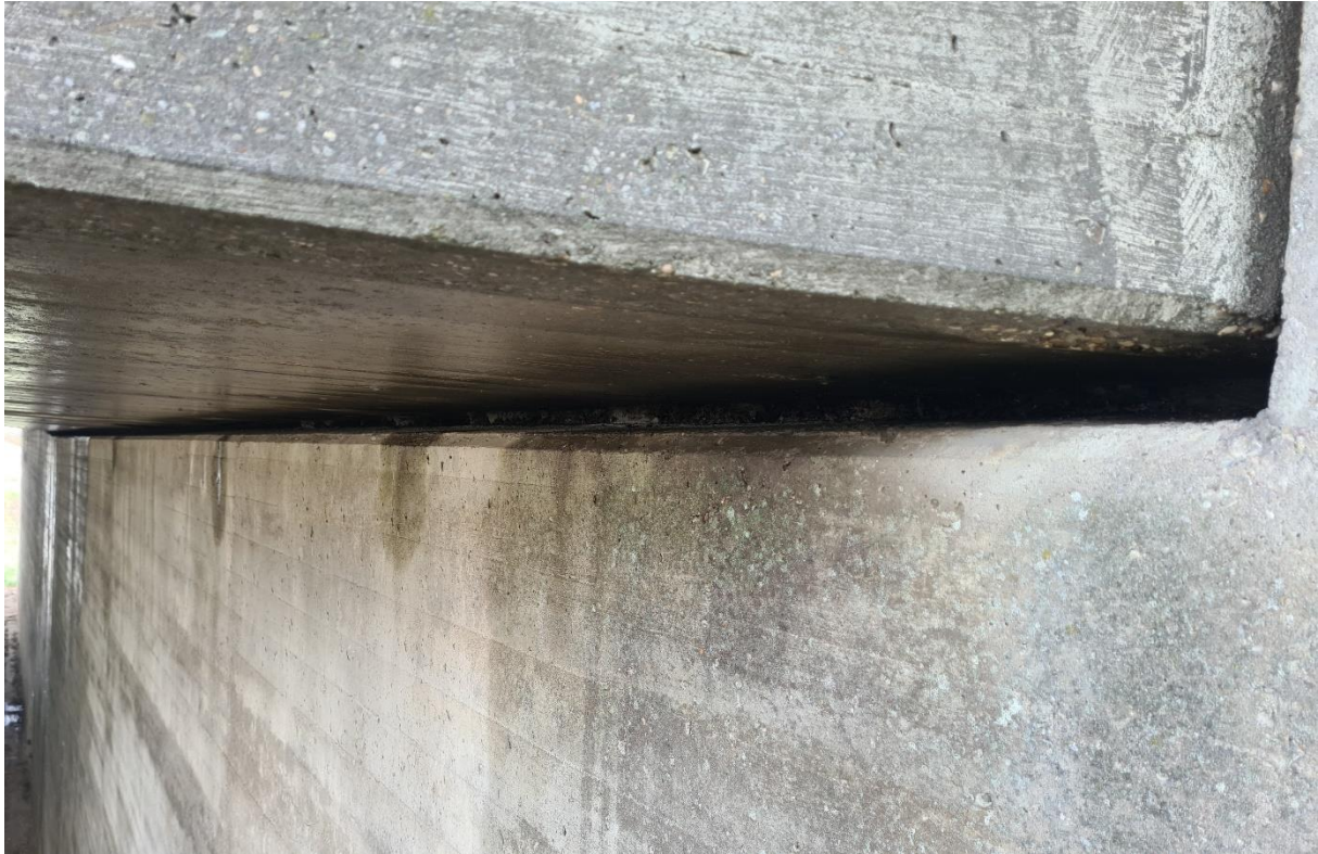
Abbildung 4: Hohraum unter dem Überbau auf der Westseite der westlichen Unterführung (April 2022).
